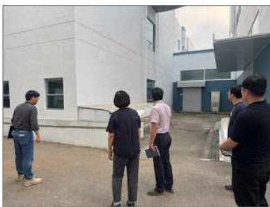
외벽 균열 및 누수 점검
